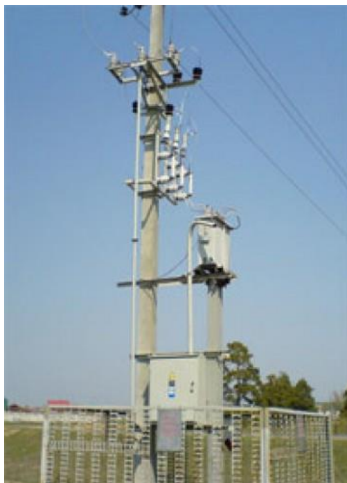
Рис. 3. Комплектная трансформаторная подстанция мачтовая КТПМ
