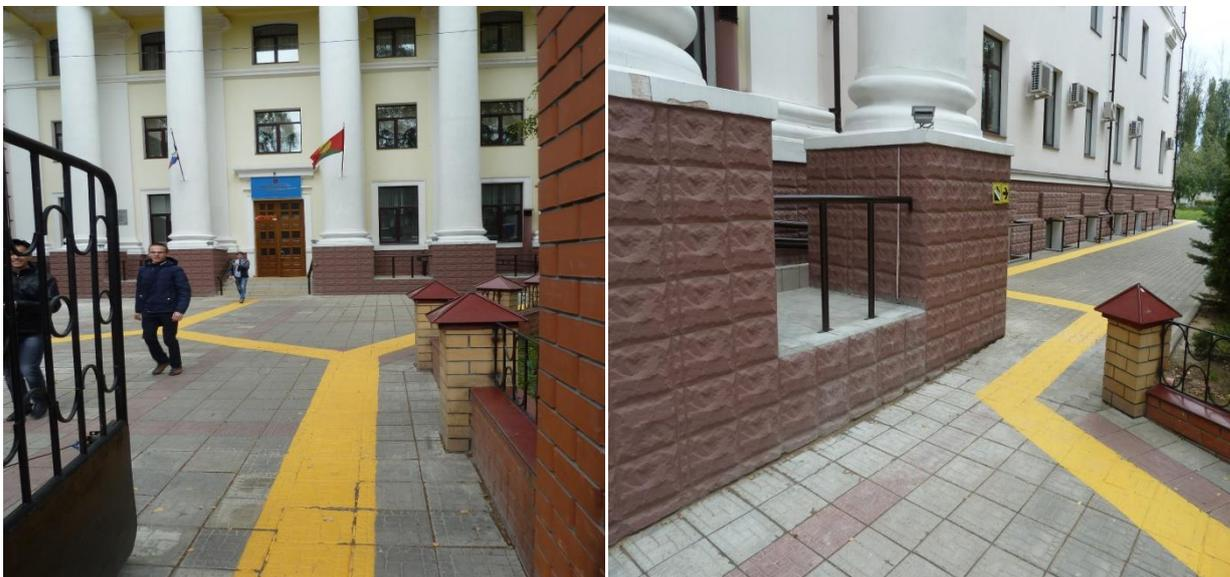
2. На территории филиала оборудована стоянка автотранспорта для ММГ, нанесены контрастные полосы направления движения, устроен пандус-спуск, установлены ограждения на пути следования МГН со автостоянки к главному входу в учебный корпус
