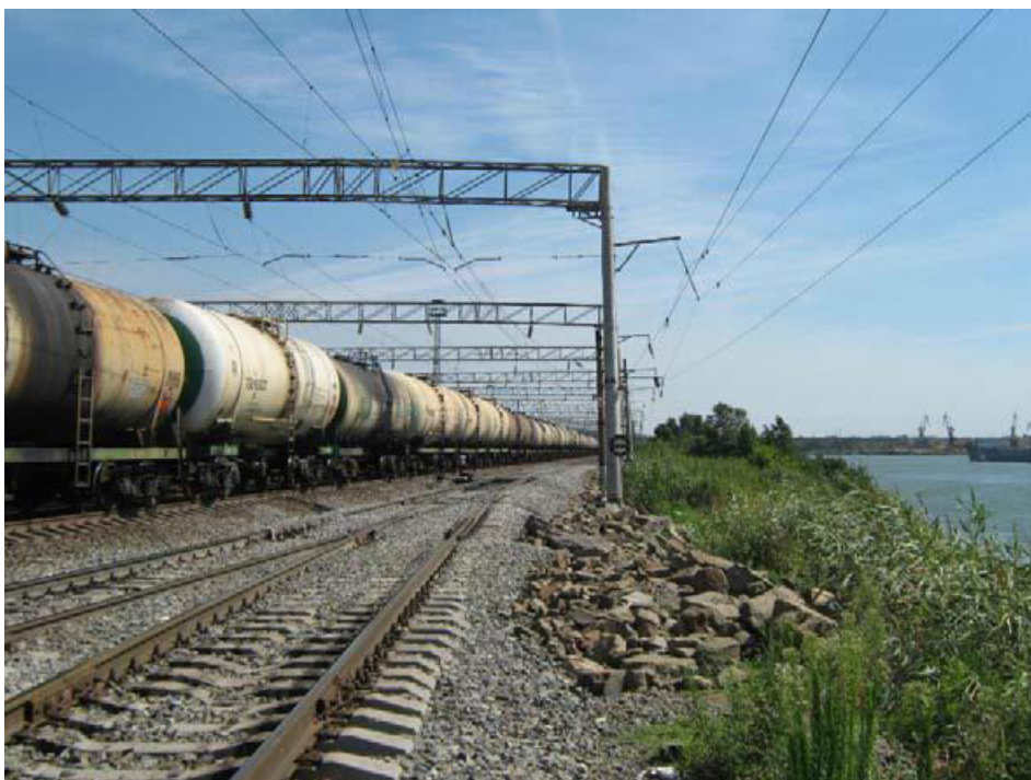
Рисунок 5.21 – Укрепление откоса бутовым камнем
