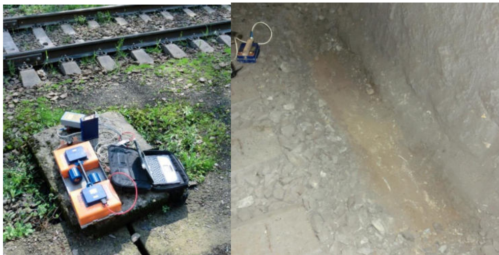
Рисунок 3.55 – Георадиолокационное оборудование, находящееся в контакте с обследуемым грунтовым слоем
