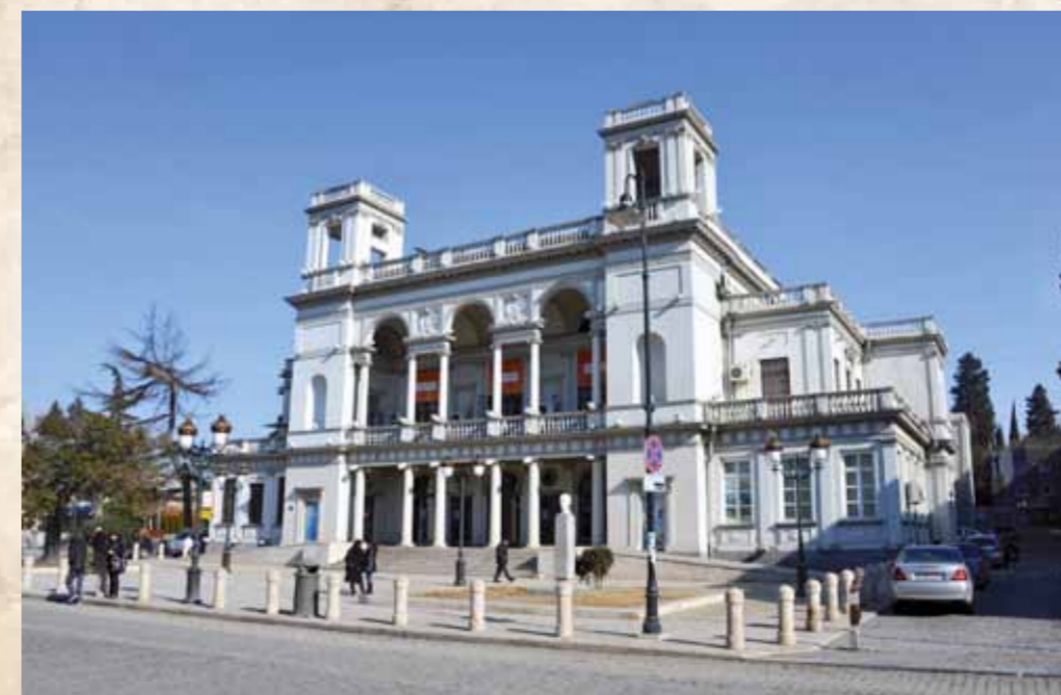
Дворец культуры железнодорожников г. Тбилиси. В этом здании располагался РИИЖТ в период эвакуации.
