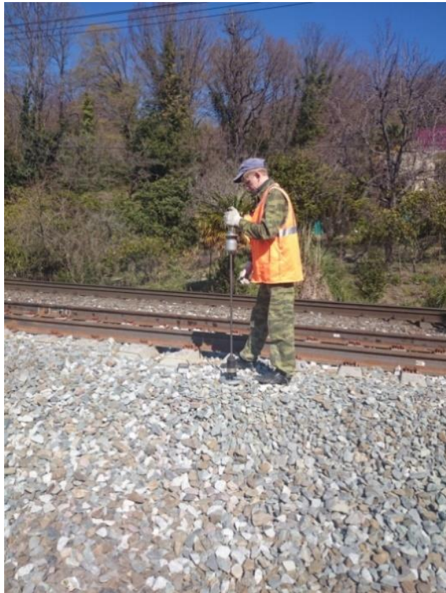
Рисунок 2.8 – Контроль качества уплотнения грунтов с помощью прибора ПДУ-МГ4
