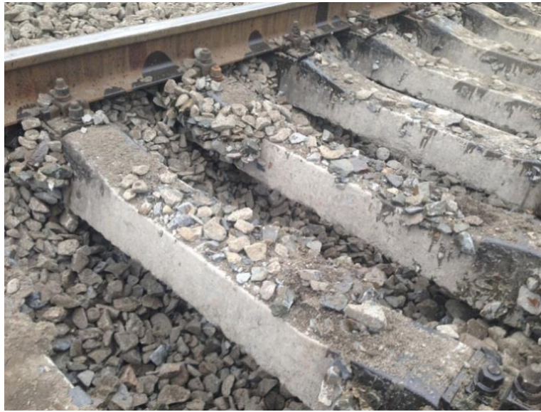
Рисунок 3.13 – Закрепленный балластный слой после работы машин тяжелого типа
