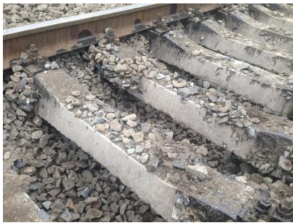
Рисунок 5 – Закрепленный балластный слой после работы машин тяжелого типа
