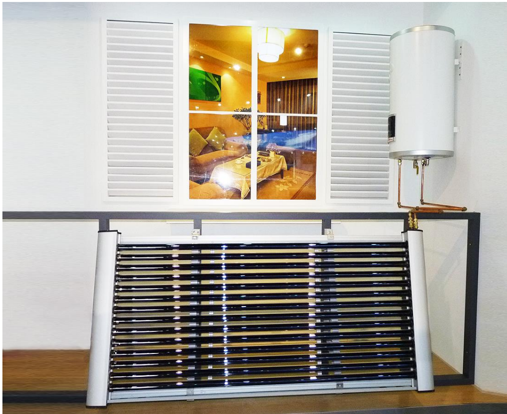
Рис. 2.14 – Пример монтажа солнечного водяного коллектора на балконе многоэтажного жилого дома
