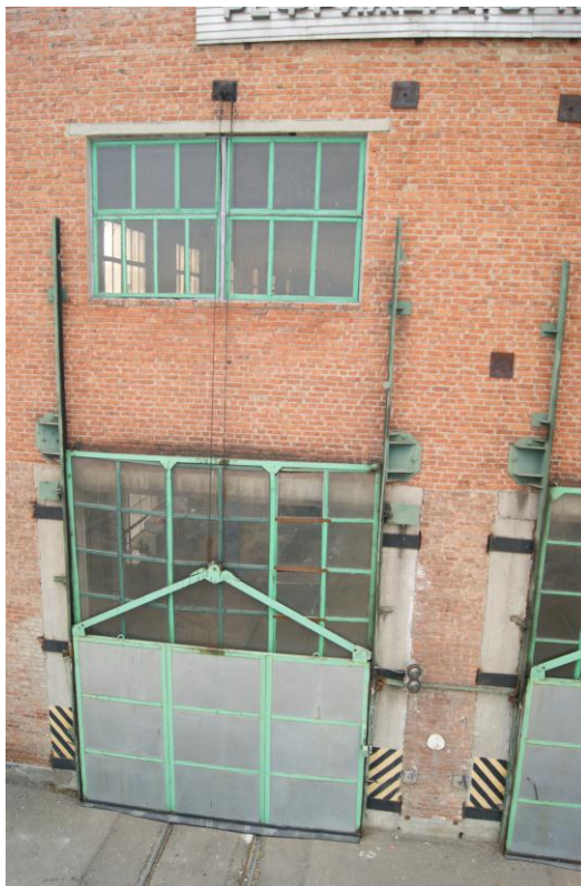
Рисунок 16 Боковой фасад промышленного здания Рефрижераторное вагонное депо г. Тихорецк
