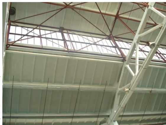
Рисунок 10 Конструкция фонаря
