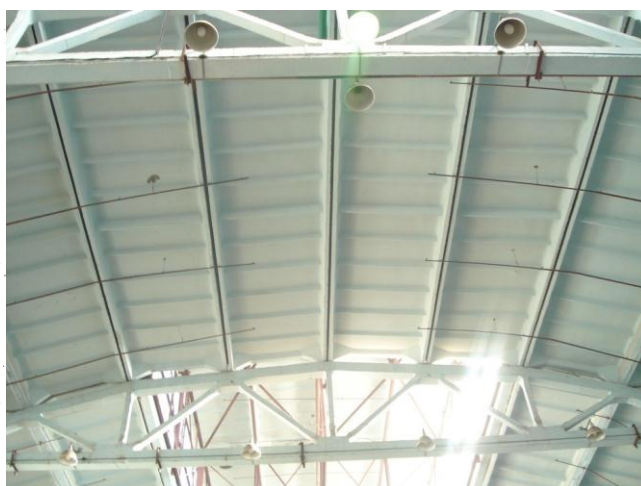
Рисунок 9 Железобетонные плиты покрытия
