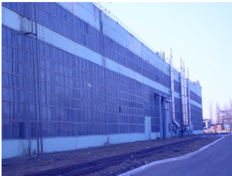
Рисунок 13 Главный фасад промышленного здания ОАО ТМЗ завод им В. В. Воровского сборочный цех
