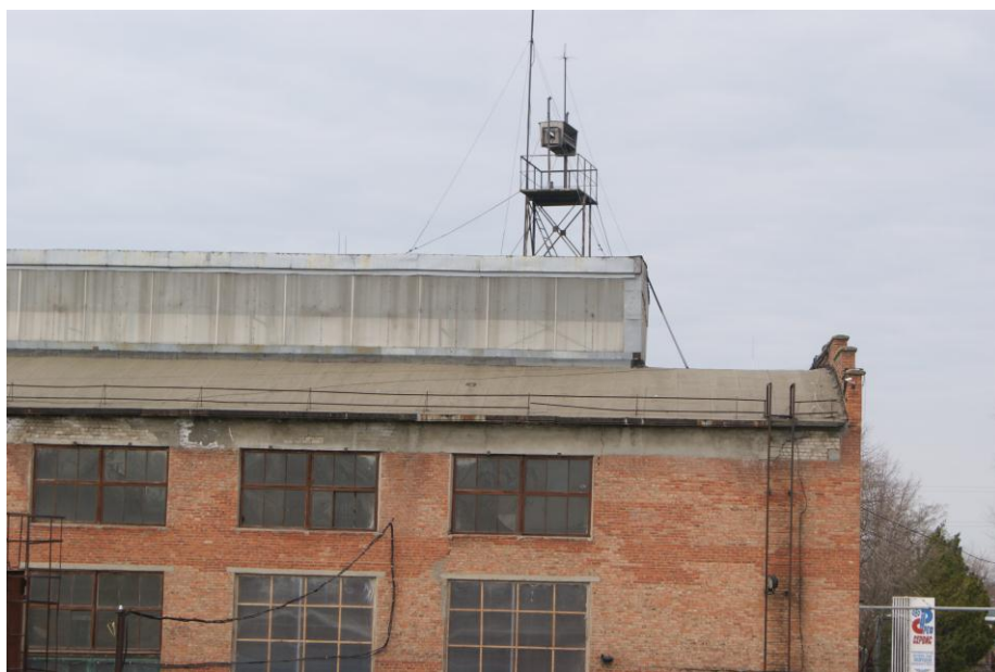
Рисунок 15 Главный фасад промышленного здания Рефрижераторное вагонное депо г. Тихорецк
