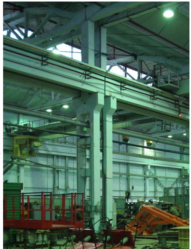
Рисунок 6 Привязка колонн к координационным осям в деформационных швах
