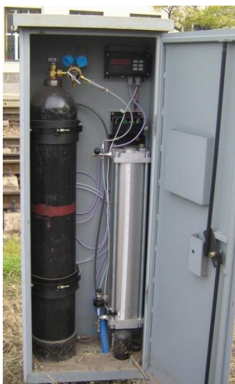
Рисунок 1.4 – Шкаф стационарного рельсосмазывателя СПР-02
